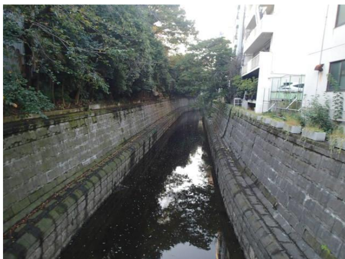
写真 2－5 古川（天現寺橋付近）整備状況
