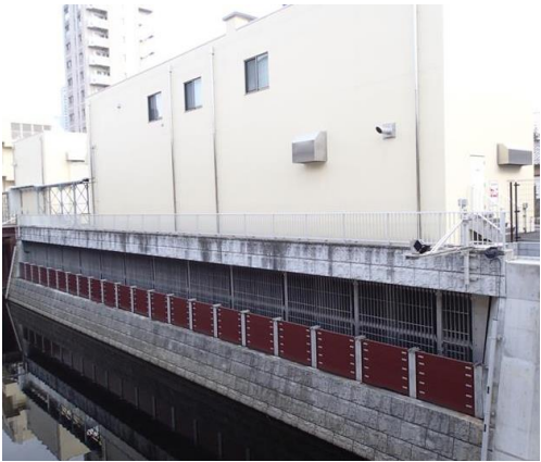
写真 2－8 養老橋下流右岸取水口
