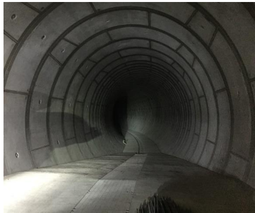
写真 2－7 古川地下調節池内部
