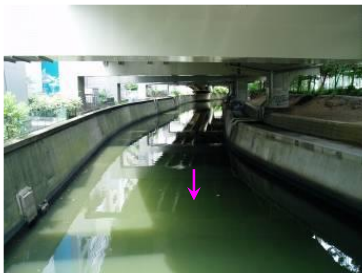
写真 4－5 芝公園付近 現況写真 (防潮堤は改修済)
