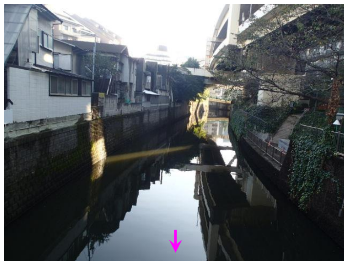
写真 4－7 三田小山町西地区 付近 現況写真
