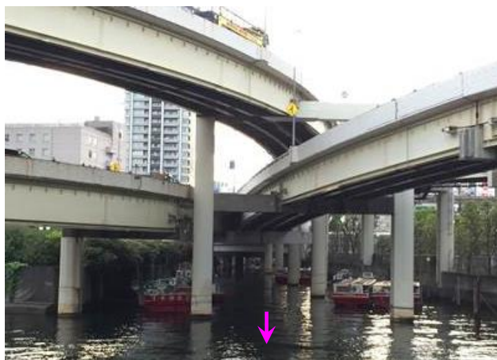
写真 4－6 河口付近 現況写真 (防潮堤は改修済)
