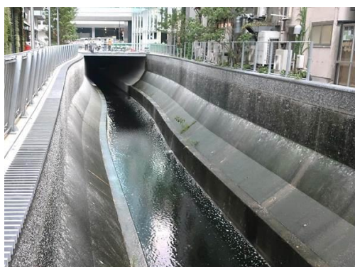
写真2-11 稲荷橋下流付近
