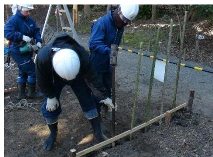
写真 18 立子設置穴を空ける
