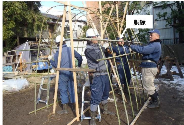
写真12 胴縁は、利用者の目線の位置で正面となる「見付き」から設置することとして、筋の良い竹を設置する
