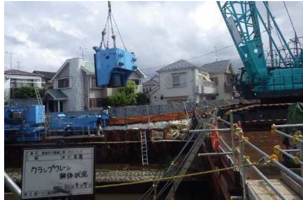
クローラクレーン解体
