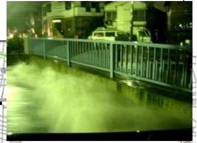
妙正寺川天神橋の様子
