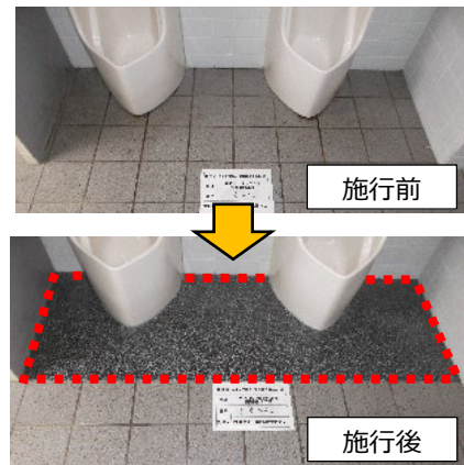
便器周りの樹脂モルタル補修により 目地をなくし、臭気定着を防ぐ(駒沢)
