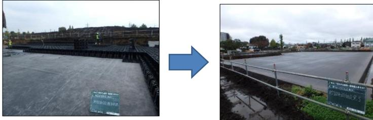
○公園外への雨水の流出を軽減するため、雨水貯水槽を設置します。
