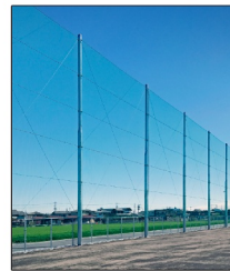
防球ネット イメージ写真 ※住宅地側は砂の飛散防止として、下部2mに防砂ネットを設置します。
