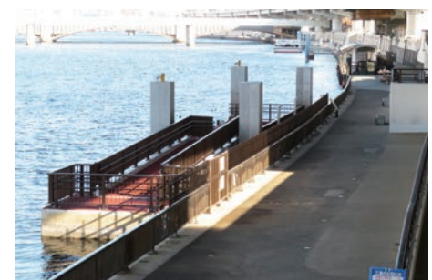
増設した小型船舶用防災船着場
