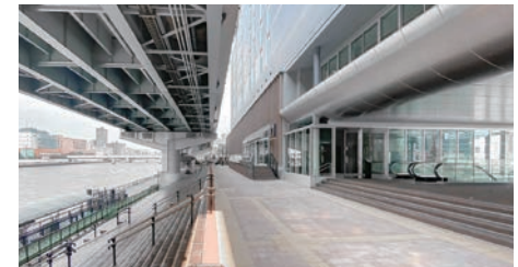
複合施設と一体的に整備したスーパー堤防
