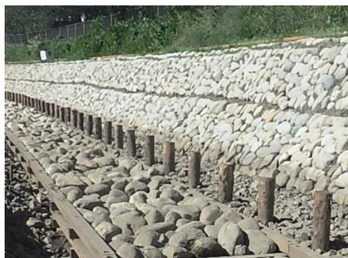
写真－1 木工沈床及び自然石固着金網
