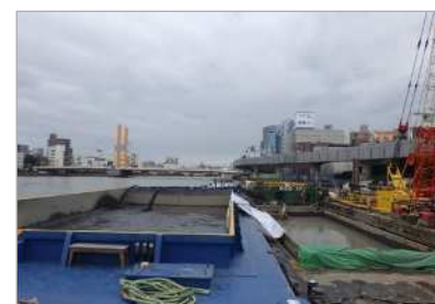
図-4 大型開閉式土運船への積替
