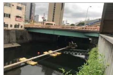
図-3 圧送管敷設状況
