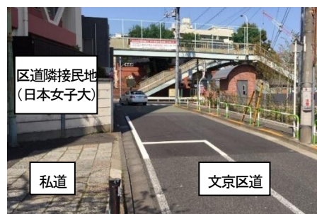
写真-3 区道部(停止線前方移設前)
