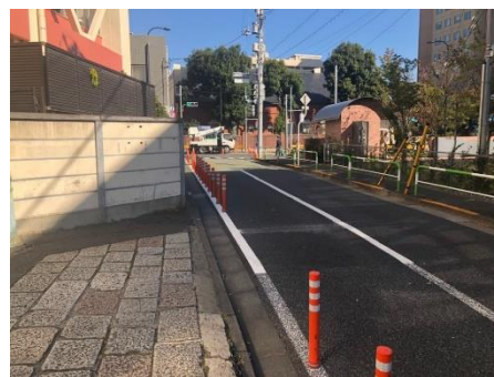
写真-4 区道部(停止線前方移設後)
