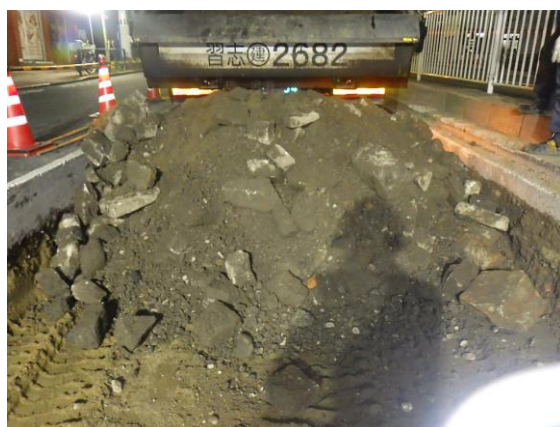
写真－1 発見されたがれき路盤
