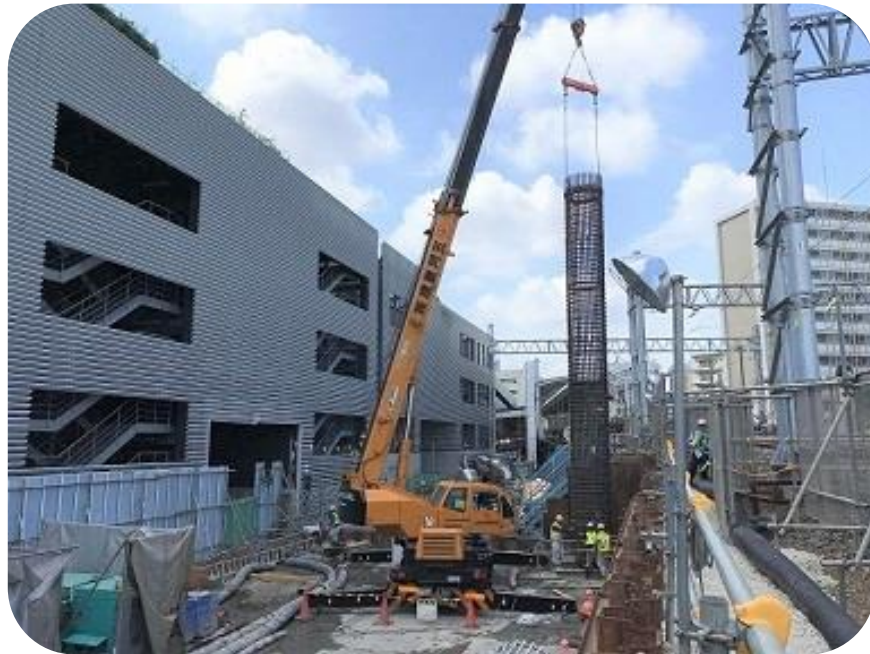
上り高架橋工事（基礎杭打設）の様子 (令和2年8月撮影)
