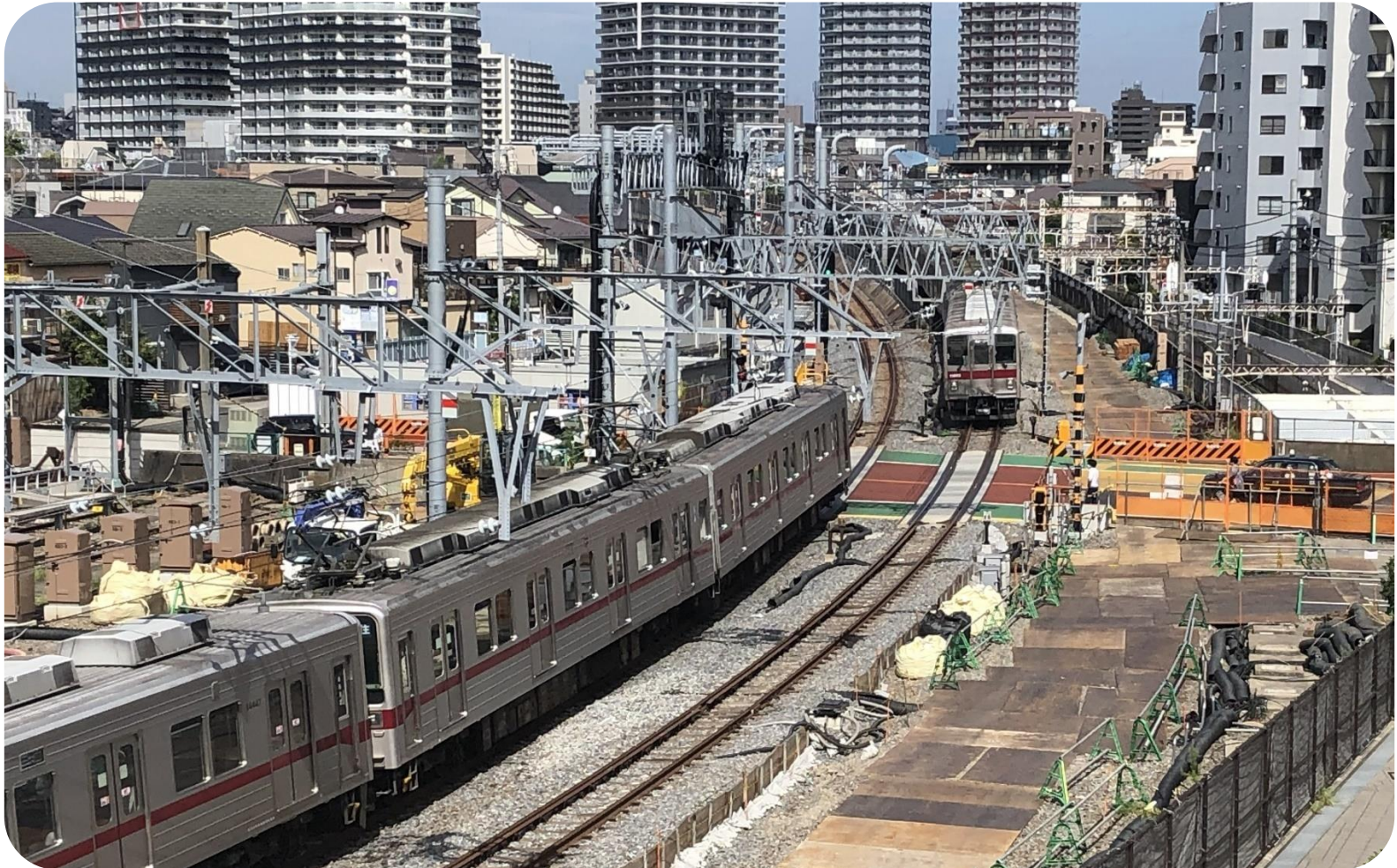
仮線移設が完了した伊勢崎線第2号踏切付近の様子（令和2年9月撮影）
