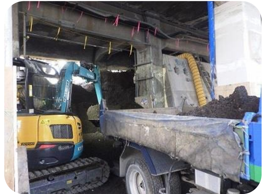
とうきょうスカイツリー駅付近工事の様子 (令和2年8月撮影)
