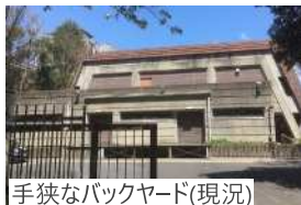
手狭なバックヤード(現況)
