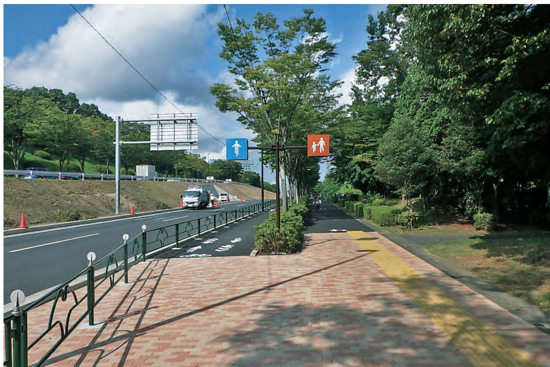
○一般都道小山乞田線 (第158号) 南多摩尾根幹線 [唐木田] 本年度、歩道・自転車走行空間の整備工事を進める。
