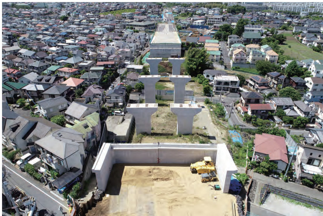
○町田3・3・36号 [旭町] (相原鶴間線) 本年度、擁壁工事や橋梁工事などを進める。
