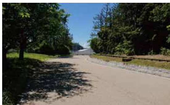
カヌー・スラロームセンター入口園路整備
