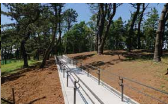
バリアフリースロープ整備
