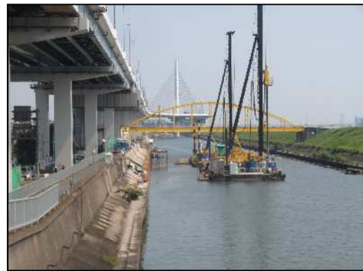
綾瀬川東四つ木避難橋上流【施工中】
