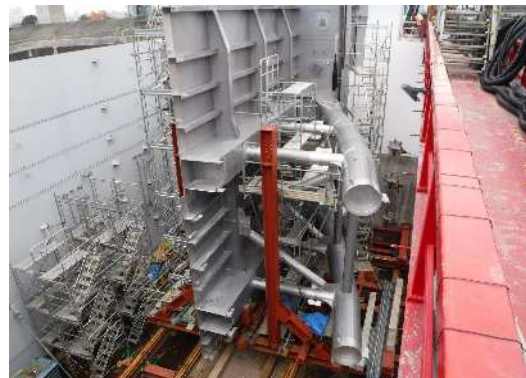
(施工状況：扉体組立)
