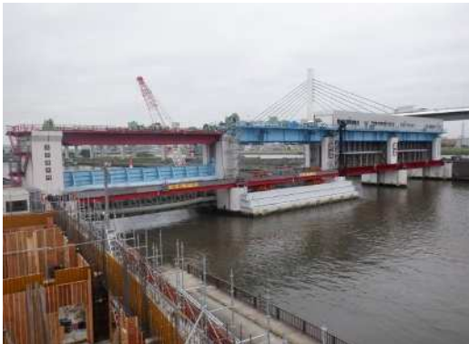
(施工状況：全景)
