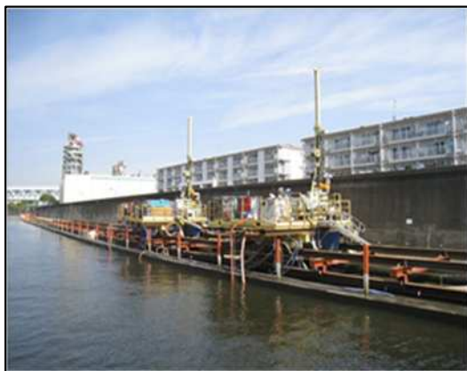
隅田川防潮堤耐震補強工事
