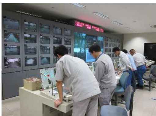
台風 15 号水門操作状況
