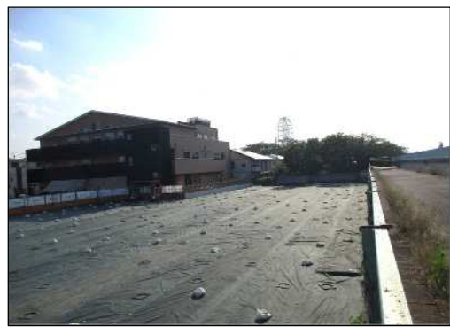
隅田川(西尾久六丁目地区)【施工前】
