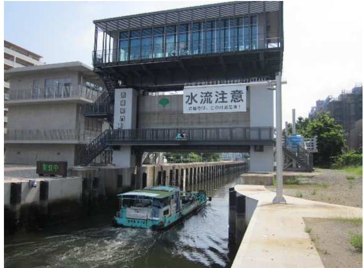
扇橋閘門の全景
