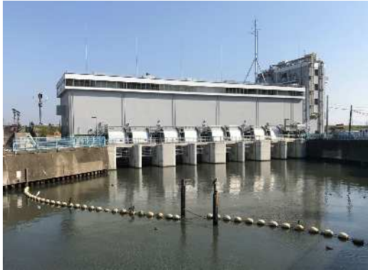
小名木川排水機場（耐震対策後）
