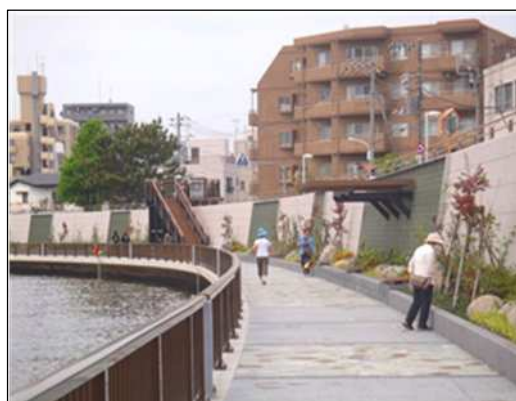
中川護岸（七曲区間）【施工後】
