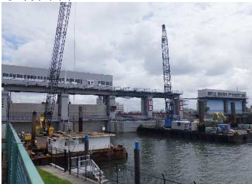
(施工状況：全景)
