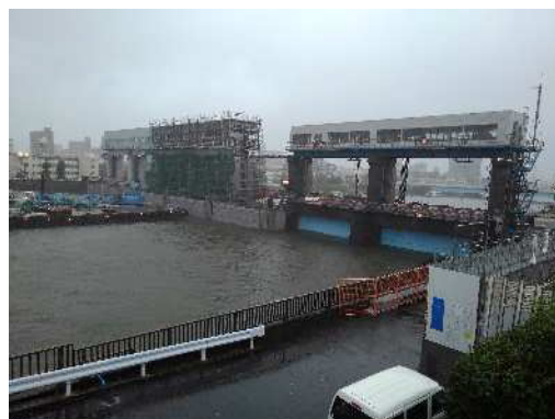
台風 19 号今井水門閉鎖状況
