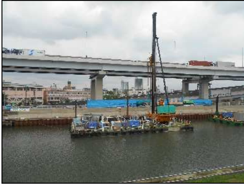
綾瀬川（新四つ木橋下流）【施工中】
