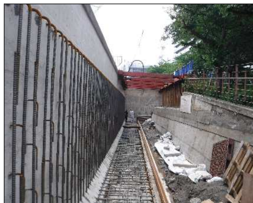
隅田川防潮堤耐震補強工事
