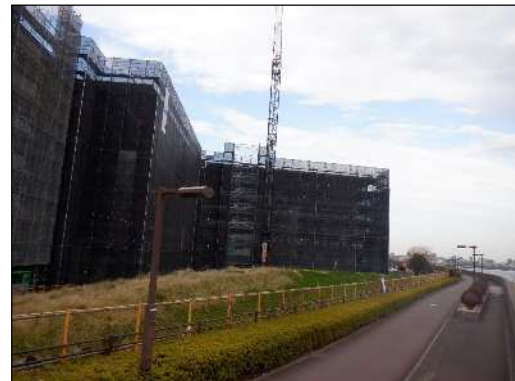
旧江戸川(東葛西九丁目地区)【施工中】
