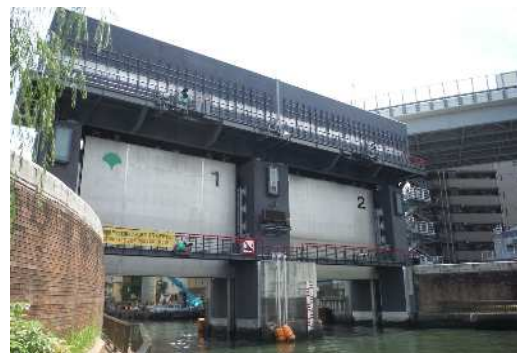
豎川水門（耐震工事完了後）
