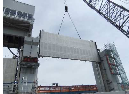
(施工状況：扉体吊込)
