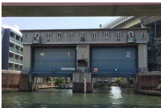
豎川水門（耐震工事施工前）
