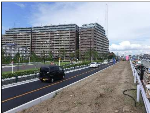
旧江戸川(江戸川二丁目地区)【施工中】
