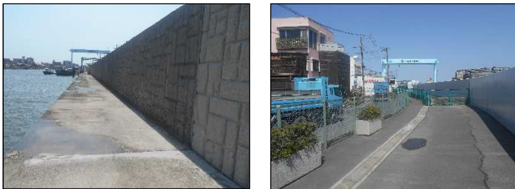
旧江戸川（妙見島）【施工前】
