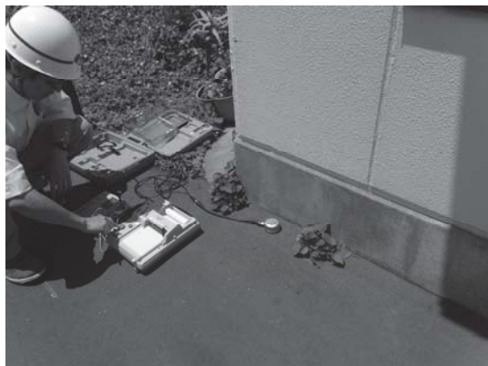
道路交通振動調査
