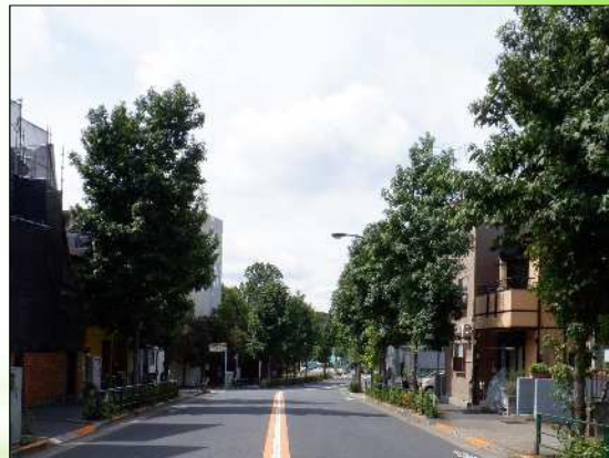
○ 無電柱化された五日市街道 （成田東三丁目付近）
