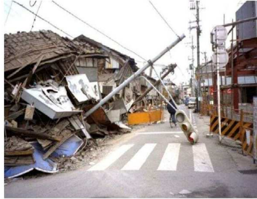
阪神・淡路大震災での倒壊電柱（国交省HP）
