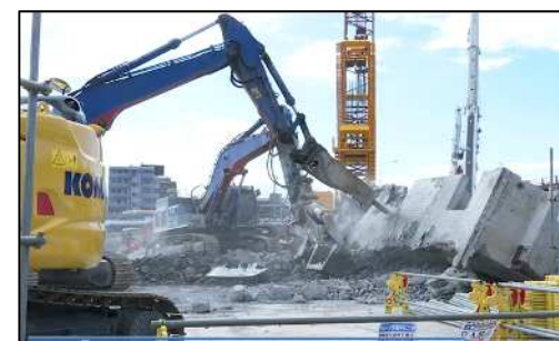
桁取壊し状況
