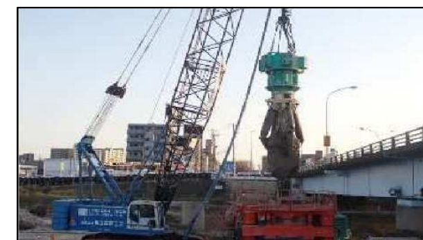
油圧式圧砕機による基礎撤去状況
