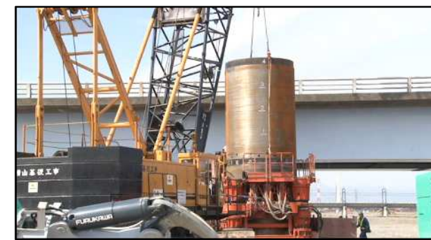
ケーシングチューブ据付け状況
