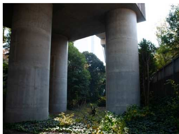
② 跨線橋橋脚 (平成30(2018)年12月4日撮影)
