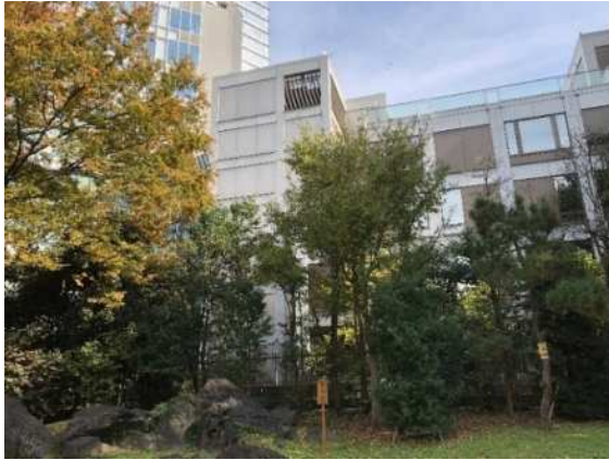
③庭園外周部（東側）植栽 （平成 30(2018)年 11 月 21 日撮影）
