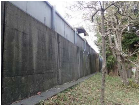
⑤庭園外周部（西側）擁壁 （平成 31(2019)年 3 月 16 日撮影）
