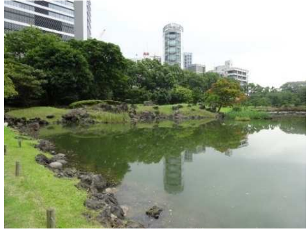
④護岸 令和元(2019)年7月18日撮影)
