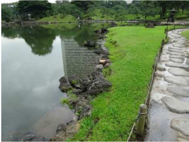
③護岸 (令和元(2019)年7月18日撮影)
