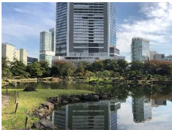
①庭園外周部（東側）遠景 （平成 30(2018)年 11 月 21 日撮影）
