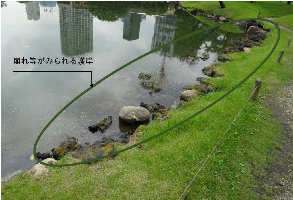
図Ⅲ-4-1：護岸の破損状況 (令和元（2019）年7月18日撮影)
