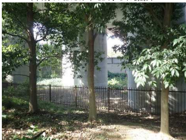
⑤芝生広場及び跨線橋の境界 （平成 30(2018)年 11 月 21 日撮影）
