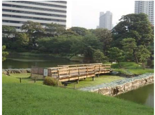
⑧木橋 (令和元(2019)年7月18日撮影)
