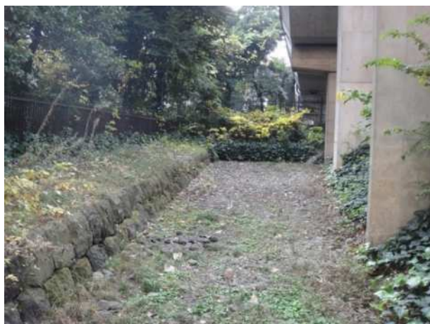
③石垣遺構（左）及び跨線橋橋脚（右） （平成 30(2018)年 12 月 4 日撮影）
