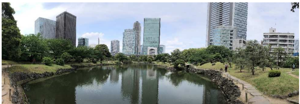
②庭園大泉水の護岸の現況（南側）（令和元(2019)年5月18日撮影）
