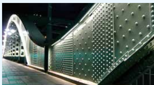
アーチリブのリベット
