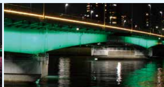
右岸下流側からのぞむ
