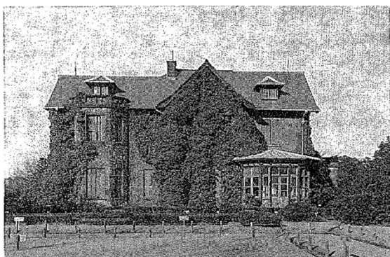
図3-15 洋館東面（整備前） 「東京都指定名勝旧古河庭園旧古河邸本館修理工事報告書」 昭和 58（1983）年頃 旧古河庭園旧古河邸修理委員会
