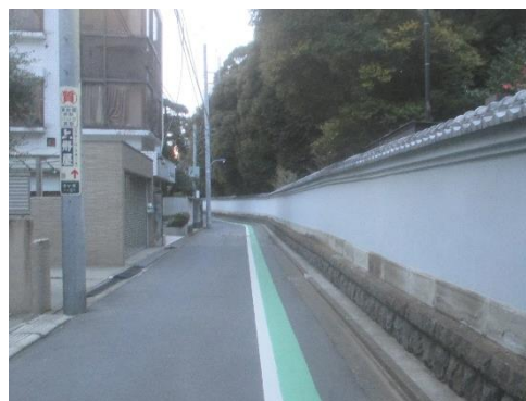
図 3-28 外周塀（整備後）
