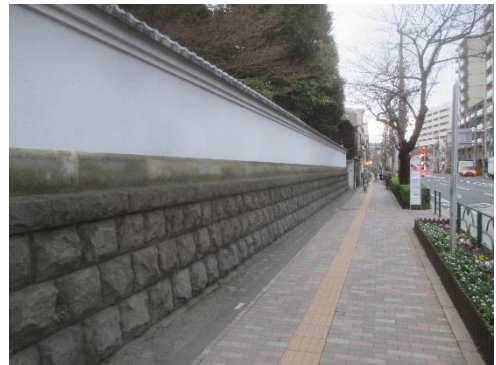
図2-188 外周塀 (平成30年12月10日)
