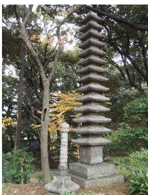
図2-183 多層塔 （平成30年12月10日）
