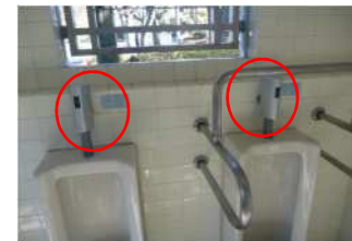
トイレの臭気改善や清潔トイレ改修の要望により水洗センサーの設置 (武蔵野公園)
