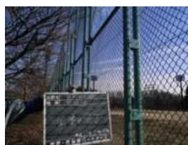
野球場フェンスの鋼材塗装 (武蔵野公園)
