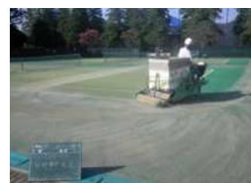
人工芝テニスコートの不陸修繕 (野川公園)
