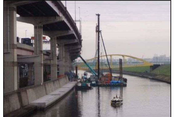
綾瀬川護岸耐震補強工事【施工状況】
