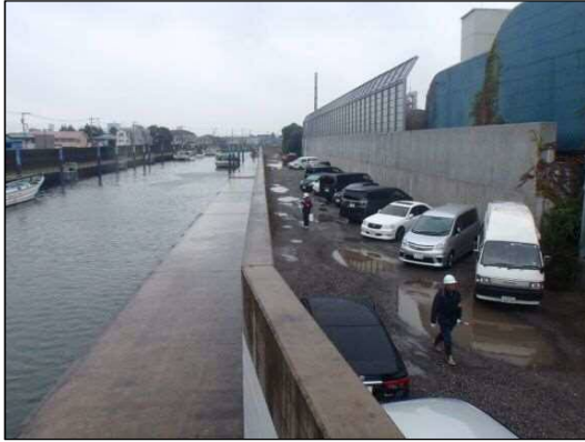
旧江戸川（妙見島）【施工前】
