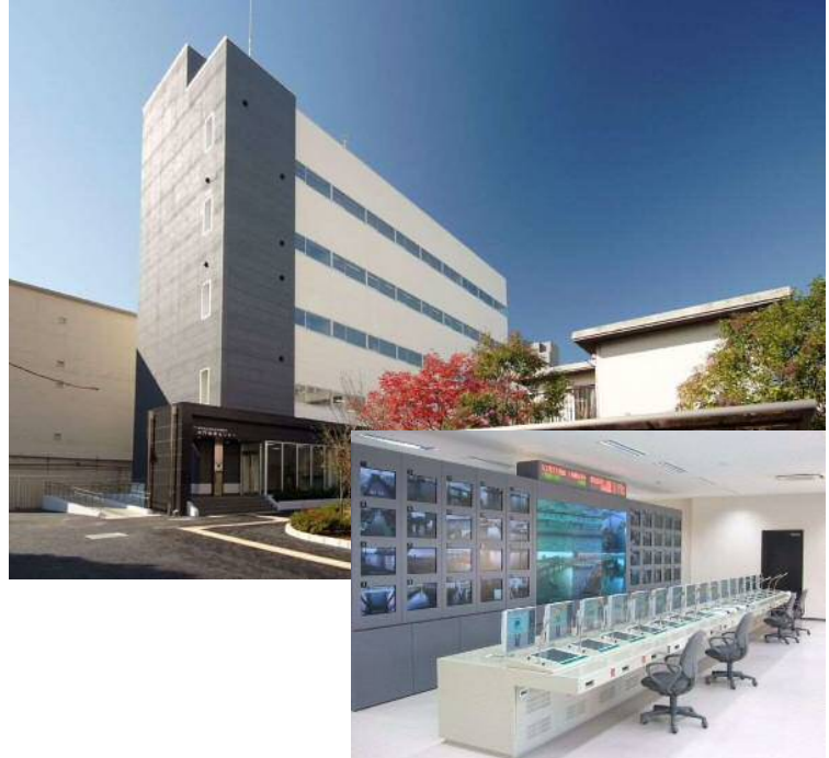
水門管理センター
