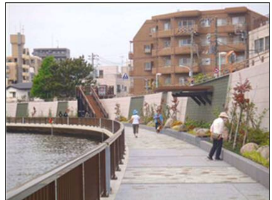
中川護岸（七曲区間）【施工後】
