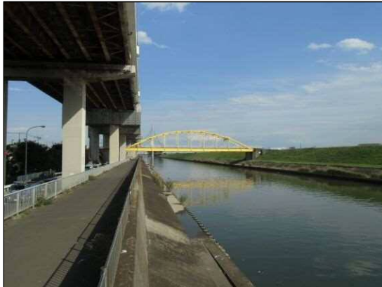
綾瀬川護岸耐震補強工事【施工状況】
