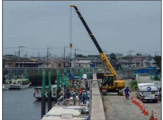
旧江戸川（妙見島）防潮堤耐震補強工事【施工中】
