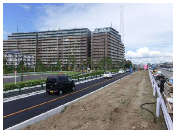
旧江戸川（江戸川二丁目地区）【施工中】
