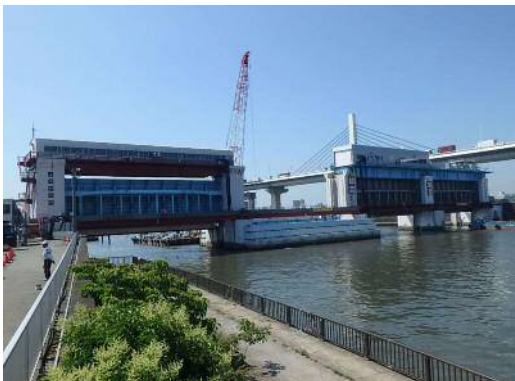
（施工状況：全景）
