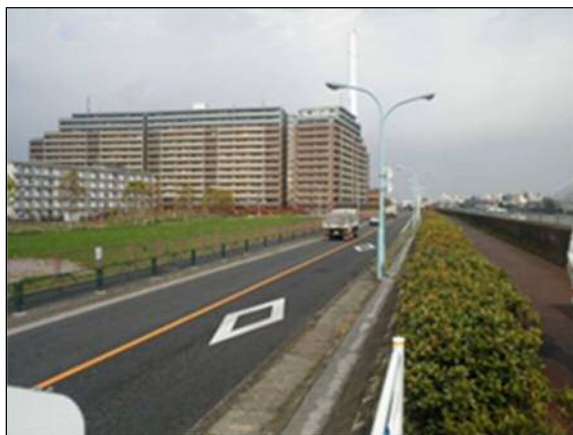
旧江戸川（江戸川二丁目地区）【施工前】
