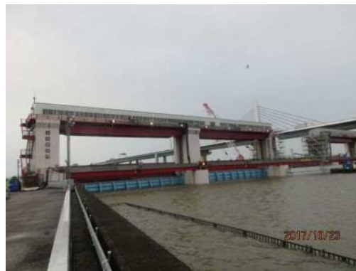
上平井水門閉鎖状況
