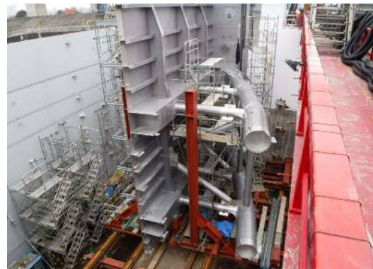
（施工状況：扉体組立）
