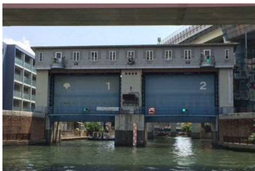
豎川水門（耐震工事施工前）
