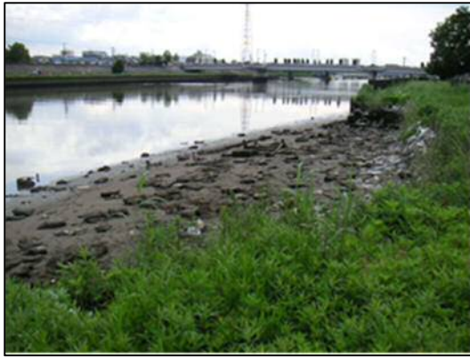
新中川低水護岸整備【整備前】
