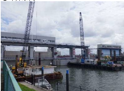
（施工状況：全景）
