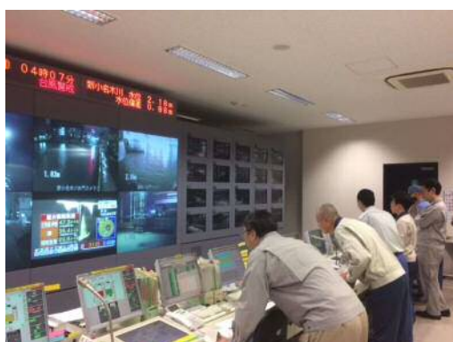
水門管理センター遠隔操作
