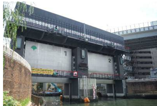
豎川水門（耐震工事完了後）
