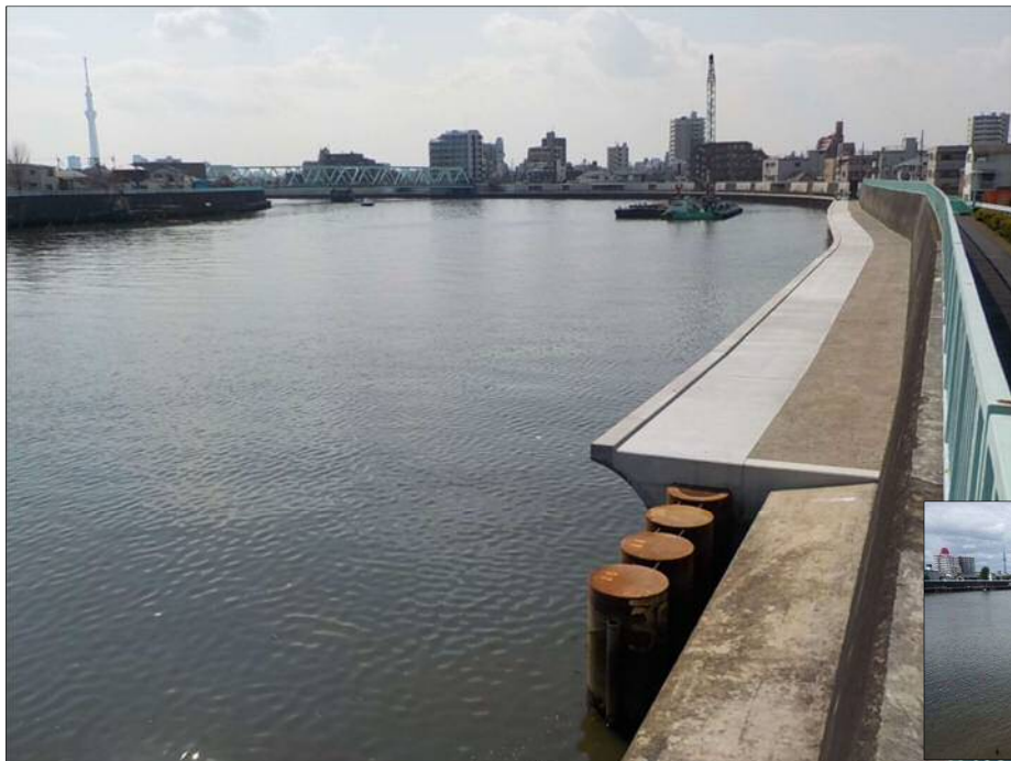
中川護岸耐震対策事業の整備（本奥戸橋上流右岸）：葛飾区立石八丁目
