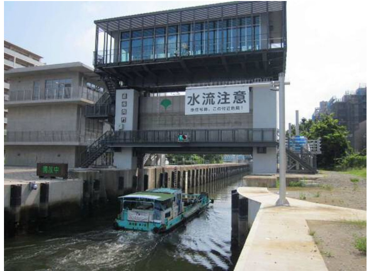
扇橋閘門の全景
