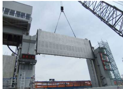
（施工状況：扉体吊込）
