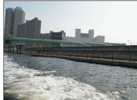
隅田川（三河島地区地区）【被覆完了】
