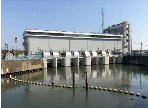
小名木川排水機場（耐震対策後）
