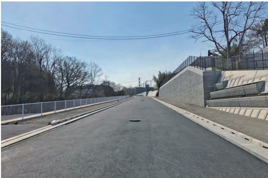
○主要地方道町田調布線（第19号）【坂浜平尾】 本年度、交通開放を行う。引き続き、電線共同溝工事を進める。
