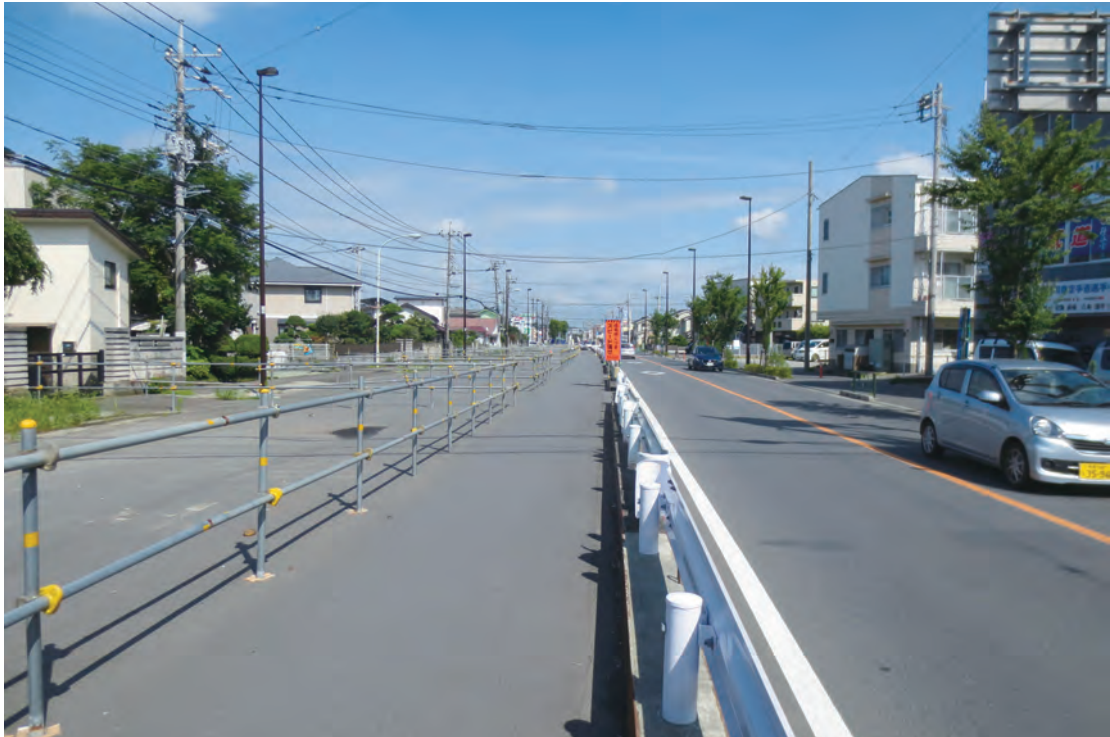
○主要地方道八王子町田線（第47号）町田街道【小山Ⅱ期】 本年度、北側の街築工事を進める。
