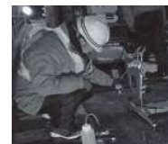
すべり測定状況(多摩部)
