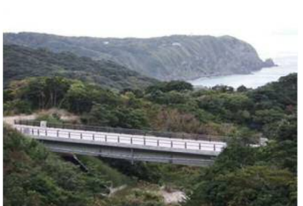
一般道神戸山多幸線(神津島村) 鍛冶山地区から鉄砲場地区の500m区間について平成28年4月に交通開放した。これにより、既設村道も含めた区間でダブルルートが確保され、地域の防災力の向上などが図られる。
