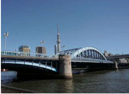
橋梁の長寿命化事業 (駒形橋:台東区雷門二丁目～墨田区東駒形一丁目地内) 隅田川に架かる駒形橋は、耐震性や耐久性などの向上を図る長寿命化工事を実施している。
