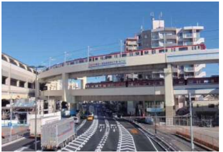
京浜急行本線・空港線(京急蒲田駅付近)連続立体交差事業 平成29年3月に事業が完了した。踏切による交通渋滞及び事故が解消されただけでなく、高架下空間の有効活用や事業を契機とした駅前再開発等、沿線まちづくりが進展している。
