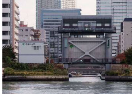
月島川水門(中央区月島三丁目地内) 平成28年度に耐震化工事が完了。大地震発生直後でも津波・高潮に対して確実に扉体が閉じて、堤防機能を確保できるように整備。
