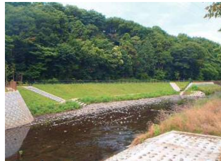
境川(町田市森野) 背後にある相模原市の公園と連携を図り、親水性に配慮した緩傾斜護岸を整備。地元の方々にも親しまれている。
