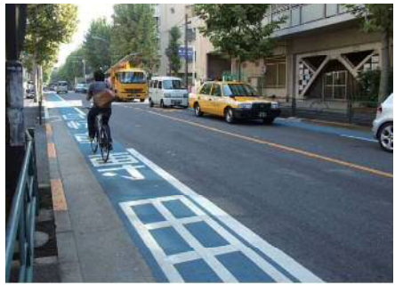
自転車走行空間整備事業(渋谷区幡ヶ谷 旧玉川水道道路) 自転車レーンや広い歩道を活用した自転車歩行者道など、地域の道路事情に応じた整備手法により、安全で快適な自転車走行空間の整備を進めている。
