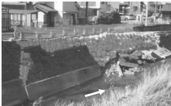
写真-2 護岸仮復旧完了
