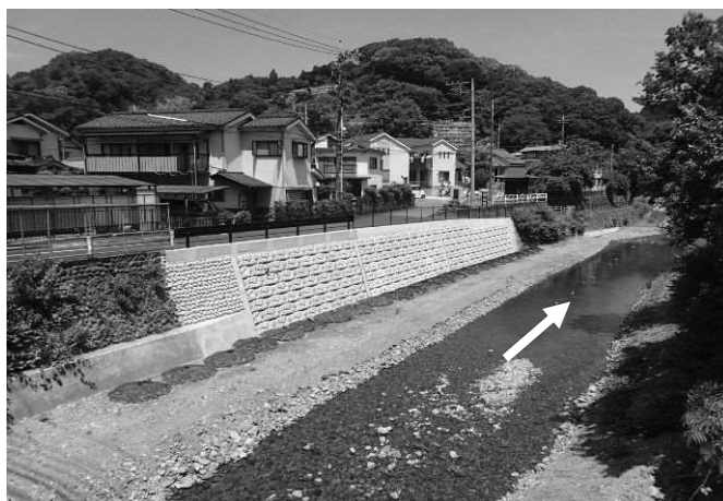
写真-3 護岸本復旧完了
