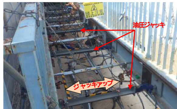
写真-3 主桁矯正状況
