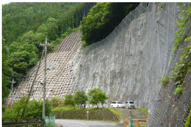
写真－4 現場風景
