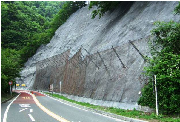
写真－１ 落石対策
