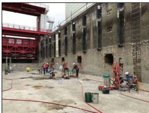
写真-1 閘室内の鉄筋挿入状況
