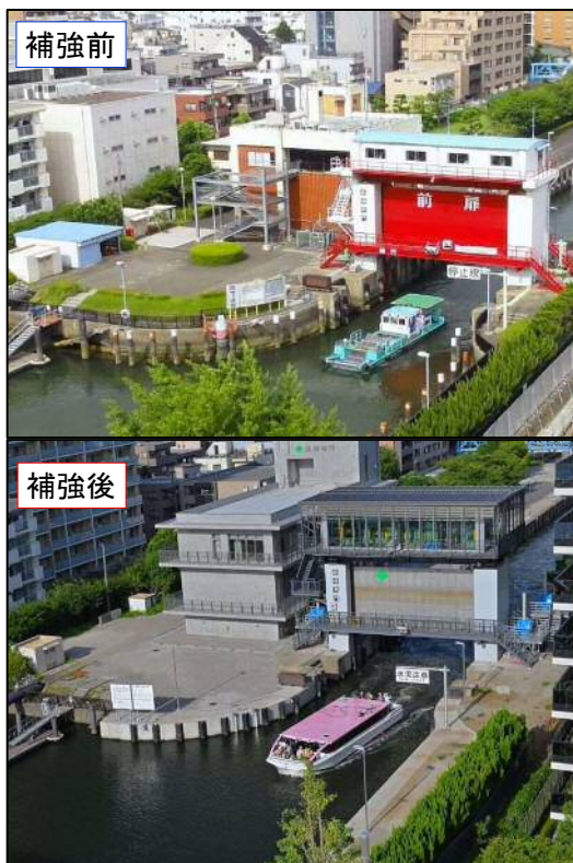
写真-2 耐震補強工事前後
