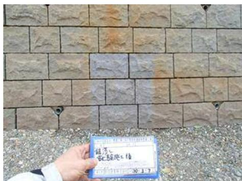
写真-2 護岸洗浄前後比較状況
