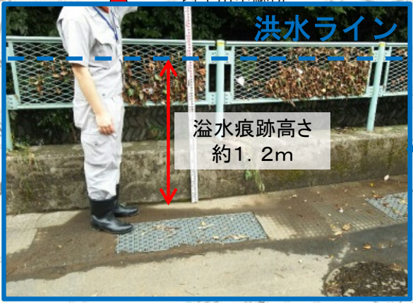
矢川橋上流 溢水痕跡状況 (H30. 8. 28撮影)
