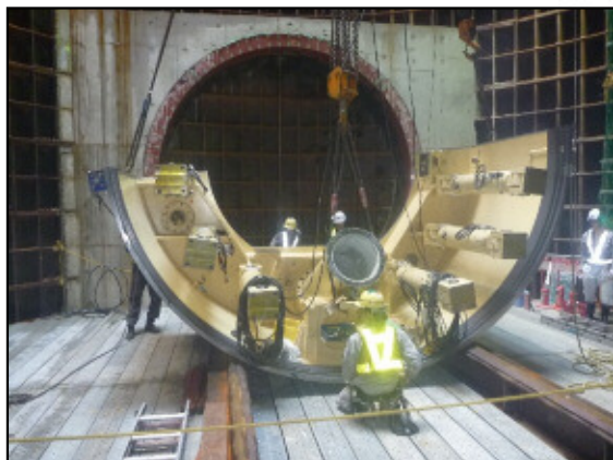
シールド機立坑内組立状況
