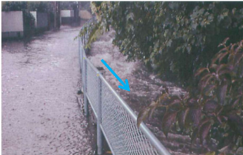
平成20年8月集中豪雨（矢川橋付近）
