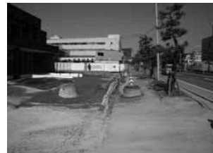
東日本大震災で発生した液状化の様子
