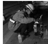
すべり測定状況
