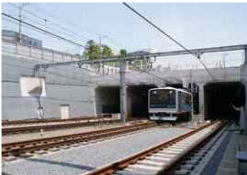
小田急小田原線(代々木上原駅～梅ヶ丘駅間)連続立体交差事業 平成31年3月に事業が完了した。鉄道の地下化により、踏切による交通渋滞及び事故が解消されただけでなく、地上部の有効活用が図られ、沿線まちづくりが進んでいる。
