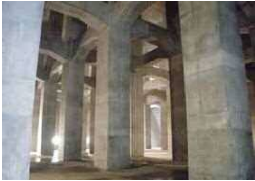
善福寺川調節池(杉並区成田西四丁目地内) 善福寺川上流の浸水被害を早期に軽減するため、都立善福寺川緑地内に貯留量約35,000m 3 の地下式の調節池を整備した。
