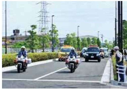
放射第5号線、三鷹3・2・2号線 令和元年6月に杉並区下高井戸から三鷹市牟礼までの約3.6kmの区間が4車線で交通開放した。これにより、区部と多摩地域を結ぶ、東京の東西方向の新たな大動脈が形成された。
