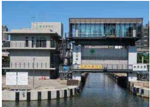
扇橋閘門(江東区猿江一丁目地内) 水位低下した東側地域と西側地域に水位差が生じるため、舟航を確保する施設として小名木川の中に設置。平成29年度から耐震・耐水工事を行っており、今年度通航を再開した。
