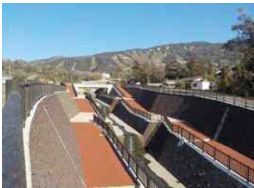
大金沢流路工(大島町元町地内) 平成25年に大規模な土砂災害が発生し、元町地区を中心に甚大な被害を受けた大金沢流域では、中長期対策として砂防堰堤等の整備を進めるとともに、流路工の改修を行っている。
