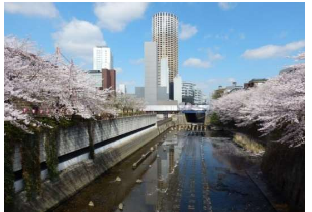
田楽橋上流取水施設
