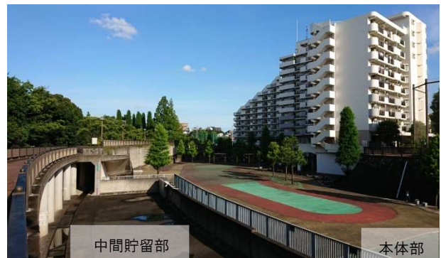
第一調節池全景
