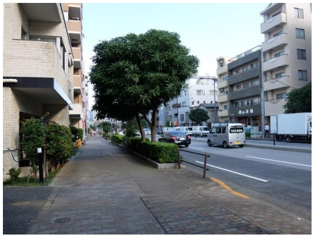
電線地中化、植樹帯設置のイメージ 放射第6号線(余丁町):幅員25m、歩道幅員4.5m
