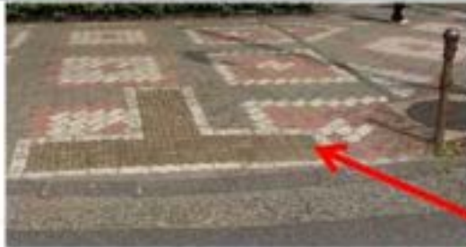
【特定事業⑤】視覚障害者誘導用ブロックの改修
