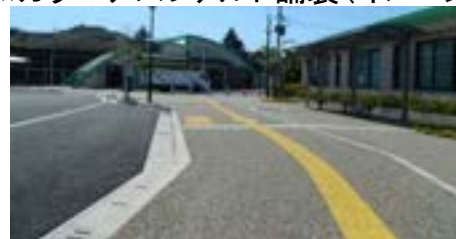
《カラーアスファルト舗装(イメージ)》
