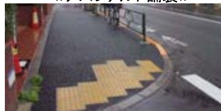
《アスファルト舗装》
