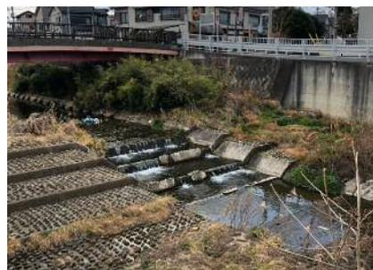
床止工及び護床工 (左) 概念図 (右) 川口川
