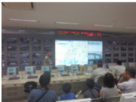
水門管理センター監視室
