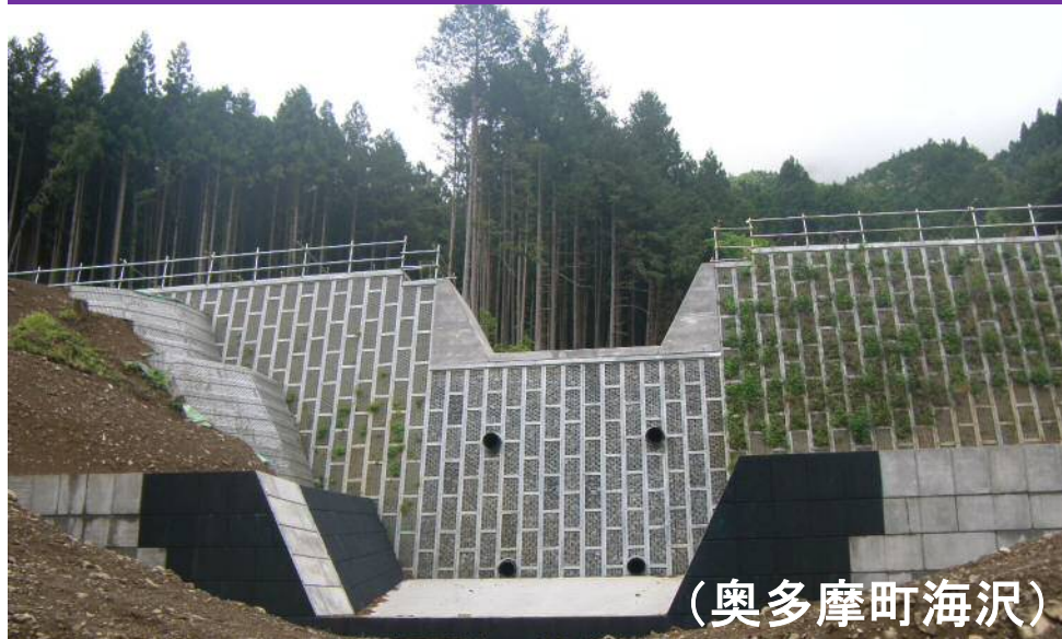
土石流を抑える砂防えん堤
