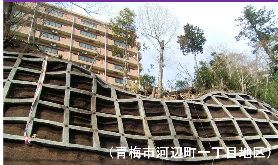
急な斜面を保全する法枠工
