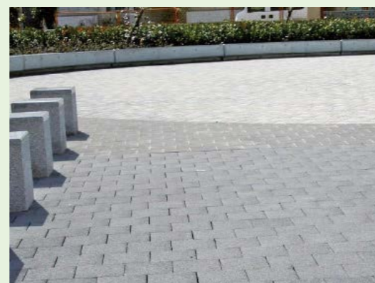
寒色系のインターロッキングブロック舗装の事例
