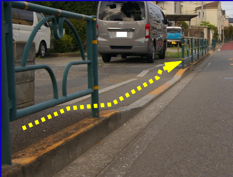
水道道路状況 猪方一丁目付近
