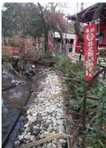
弁財天の護岸工事
