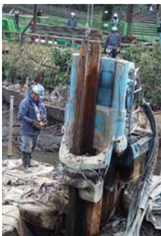
粕江橋の仕切り撤去
