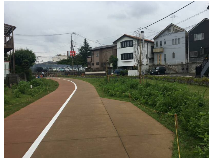
掘削土の工事間流用（旧河川を埋め戻し、散策路を整備）
