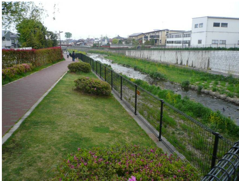
河川管理用通路の緑化
