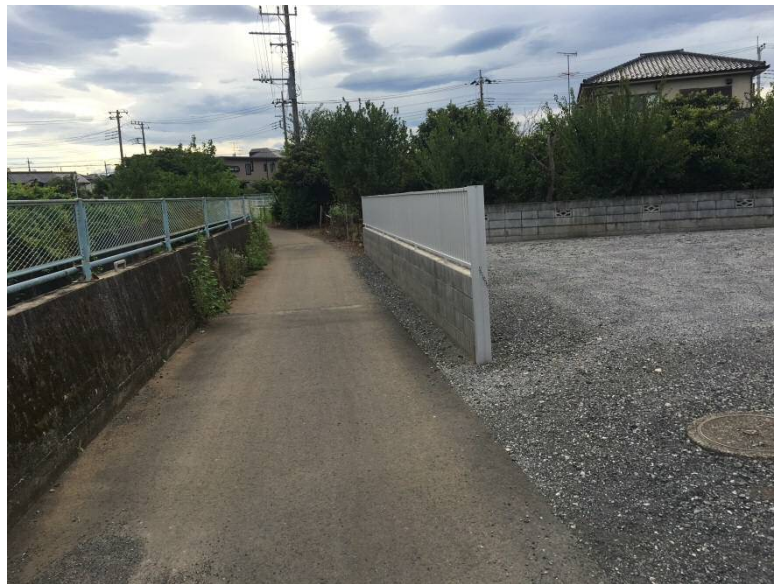
狭隘な搬入路（念仏塚橋下流左岸）
