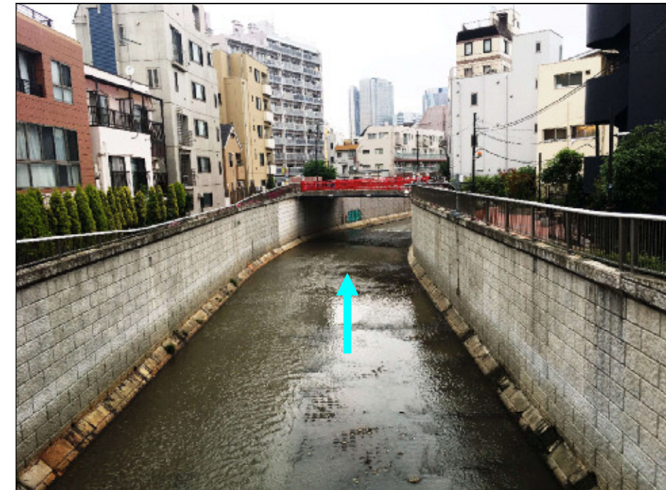
【整備後：氷川橋より新橋を望む】
