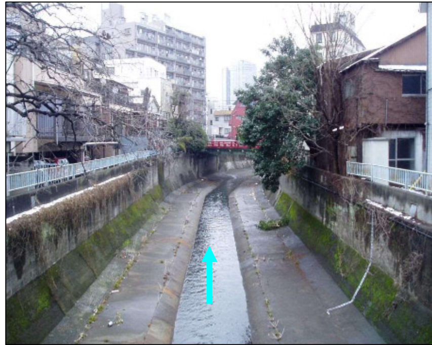
【整備前：氷川橋より新橋を望む】
