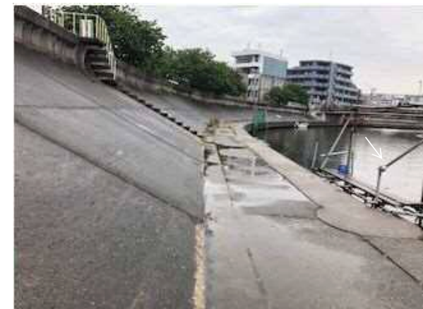
左岸側(西側)の防潮堤 (多摩川から弁天橋を望む)
